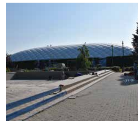
Strakonická hala ve zkušebním provozu. Foto Calypso Group
