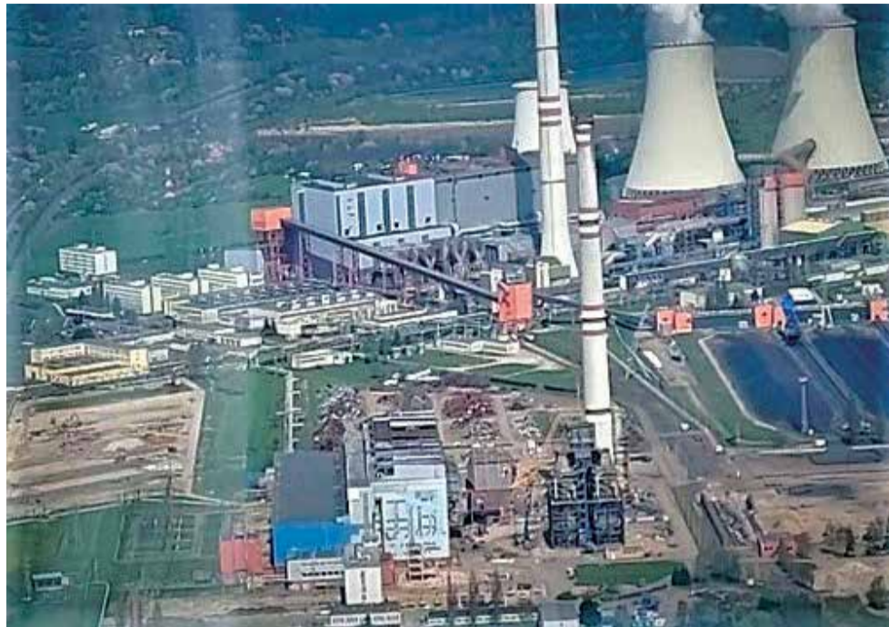
Letecký snímek, ze kterého je patrné, jak dalece likvidace elektrárny pokročila. Foto Ota Schnepf
