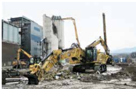
Demolice sil na vápenec. Foto O. Schnepf
