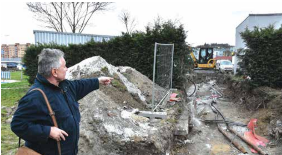
Jednatel Tepelného hospodářství Kadaň Dušan Kučera na místě stavby. Foto M. Šil
