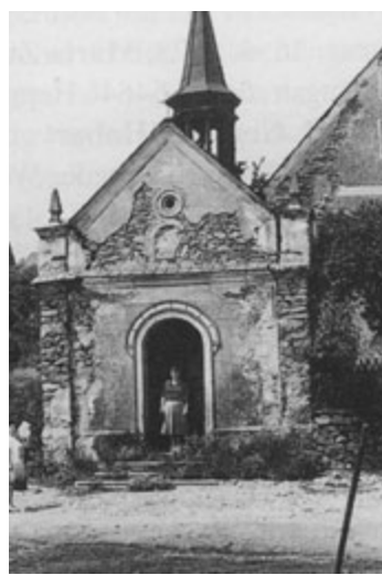
Kaple v roce 1982, poté z ní zbyly jen základy
