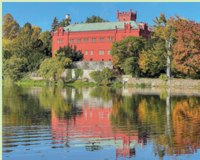
Jižní fasáda zámku po obnově
